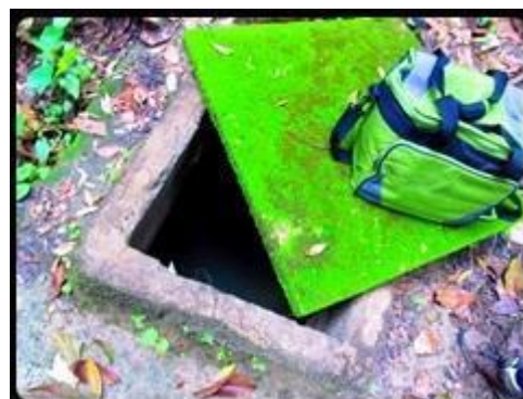
Figura 5 – Caixa d'água subterrânea do Parque Prainha
