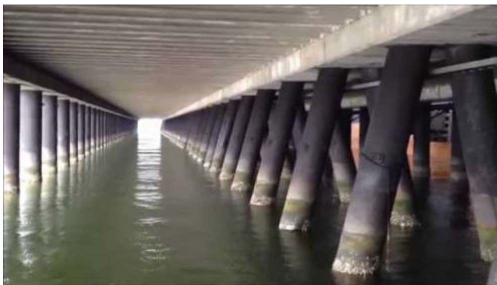
Figura 1: Pintura epóxi aplicada em estacas de concreto em píer de atracação.
