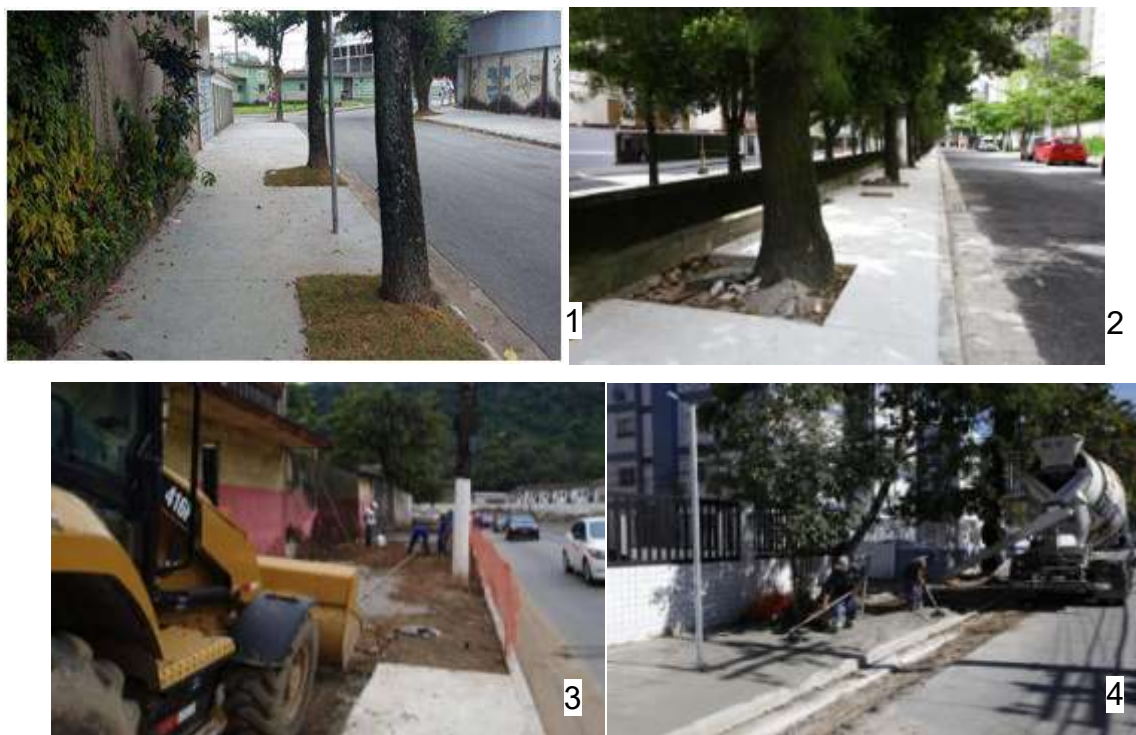
Figura 2 – Construção de passeios em concreto desempenado, com padrão de acessibilidade e segurança nos bairros Jardim São Manoel (1) , Marapé (2), Caneleira (3) e Aparecida (4)
