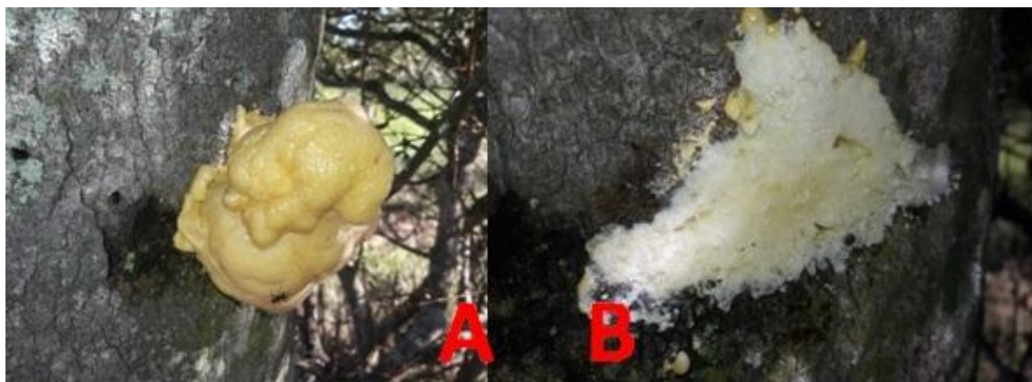
Figura 5. Espuma expansiva de poliuretano aplicada nas lesões, sobre a calda bordalesa: A) espuma expandida; B) excedente da espuma eliminado (fonte: banco de imagens do autor).
