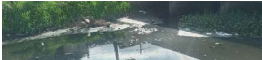
Figura 03: Avenida Acaraú com Avenida Severo Conde
