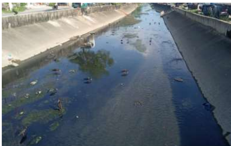
Figura 08: Avenida Acaraú, ponte sentido Centro
