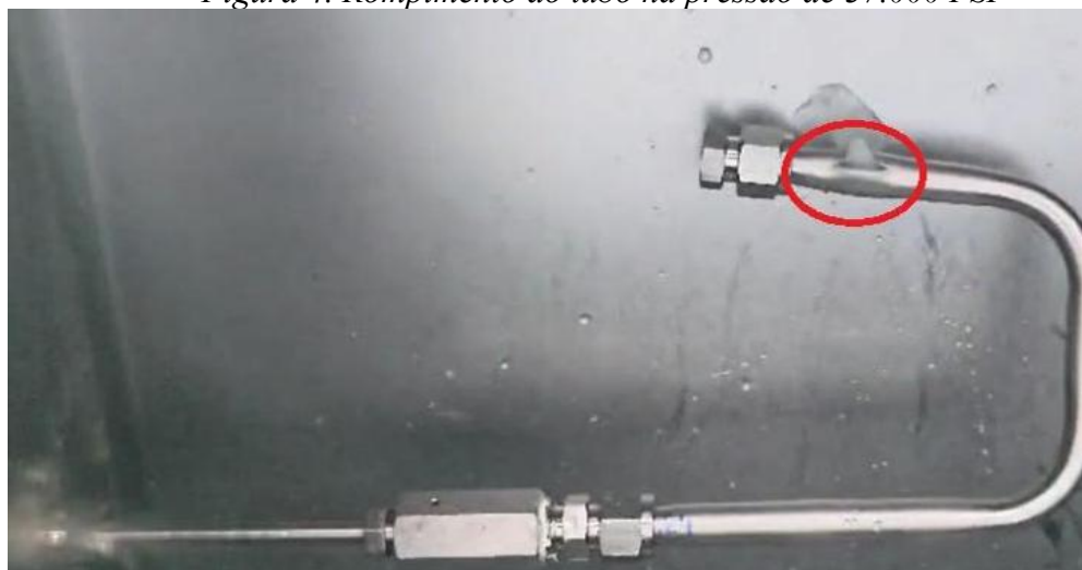
Figura 4. Rompimento do tubo na pressão de 37.000 PSI
