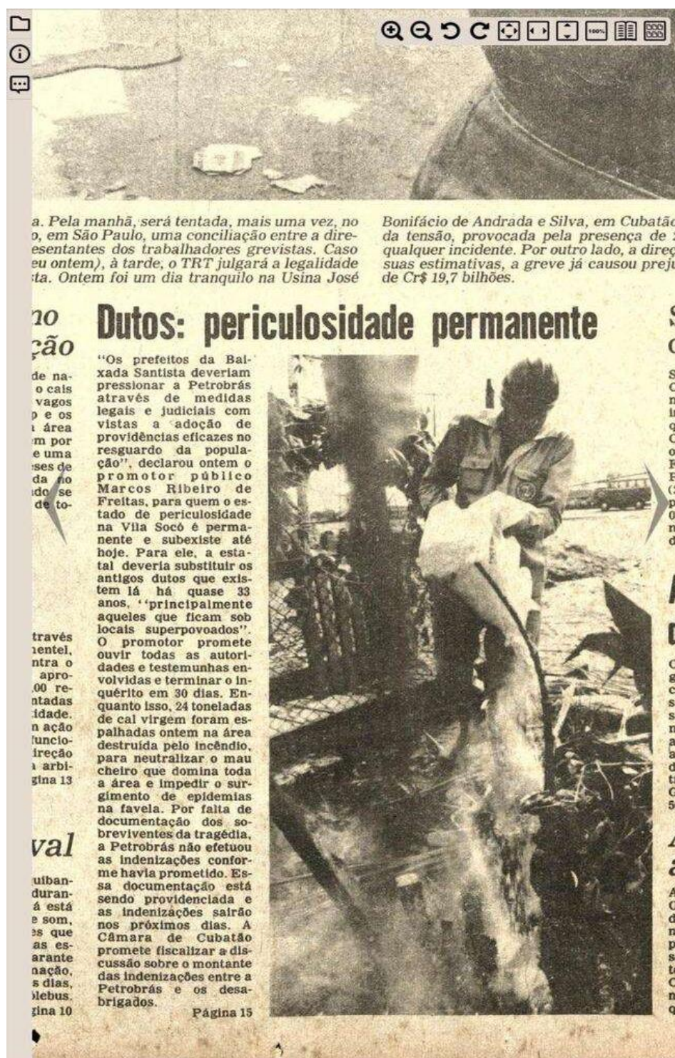
Figura 5: Os dutos perigosos. Fonte: Acervo digitalizado Cidade de Santos
