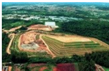
Fig. 1 Visão panorâmica Aterro sanitário
