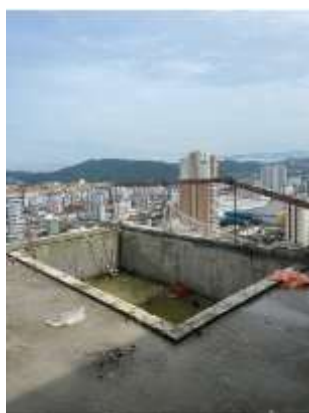
Figura 27 – Piscina Cobertura Duplex
