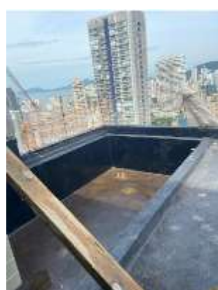
Figura 28 – Piscina Cobertura Duplex
