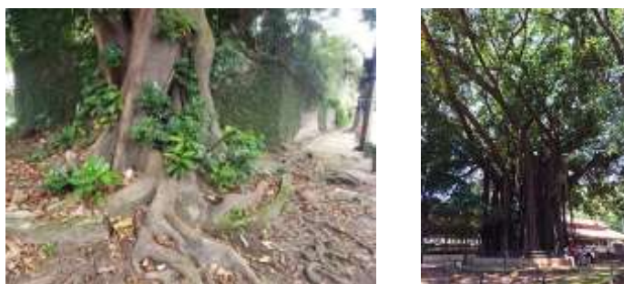
Figura 18- Raízes nos pisos e asfalto
