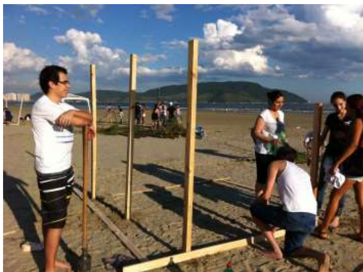
Figura 6: Montagem dos Abrigos Provisórios na praia de Santos Fonte: Cristina Ibrahim Ribas
