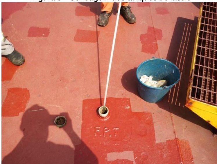
Figura 3 – Sondagem dos tanques de lastro
