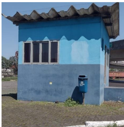
Figura 3 – Caçamba atual em um ponto de coleta de lixo na parte de regramento do porto.
