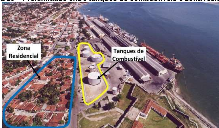
Figura 10 – Proximidade entre tanques de combustíveis e zona residencial.
