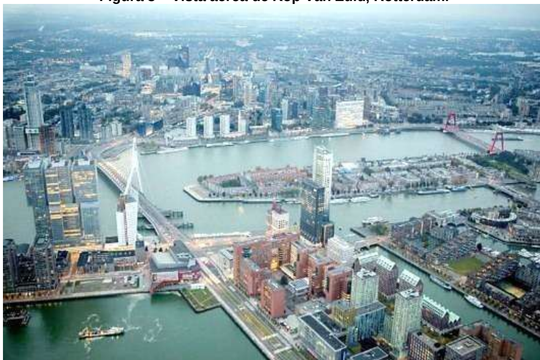
Figura 3 – Vista aérea de Kop Van Zuid, Rotterdam.
