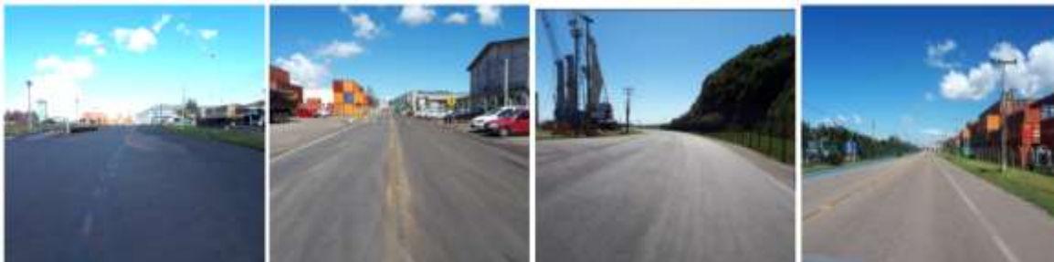
Figura 3 – Obras de manutenção das vias do Porto de Imbituba
