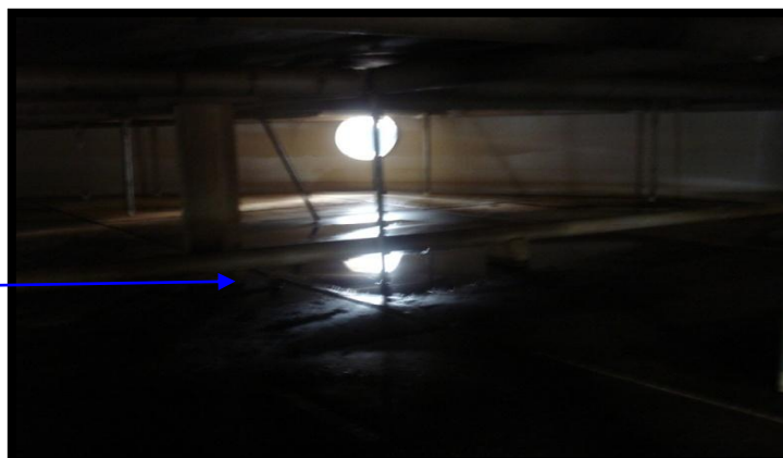
Figura 01: Lodo depositado sobre as chapas do fundo do tanque de querosene
