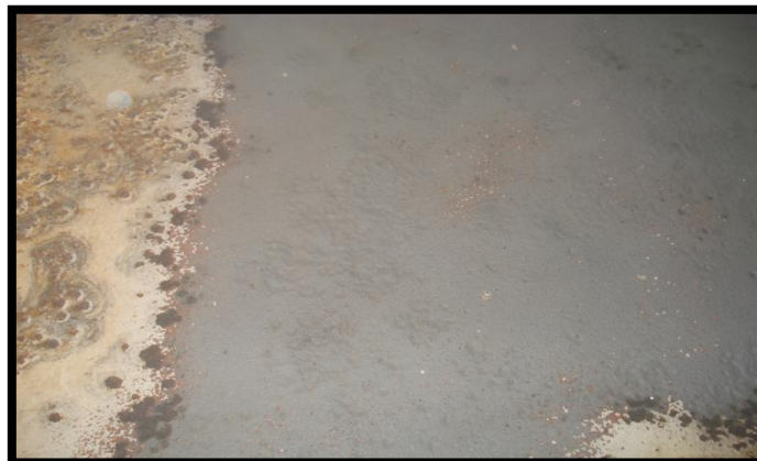
Figura 03: Chapas do fundo do tanque com corrosão bacteriana
