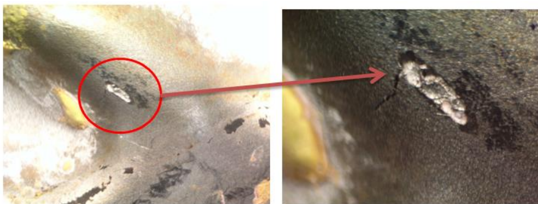
Fig. 3: Vista da superfície com dano, analisada através de um microscópio estéreo com ampliação de 10x e 40x, respectivamente, antes da preparação para análise metalográfica.
