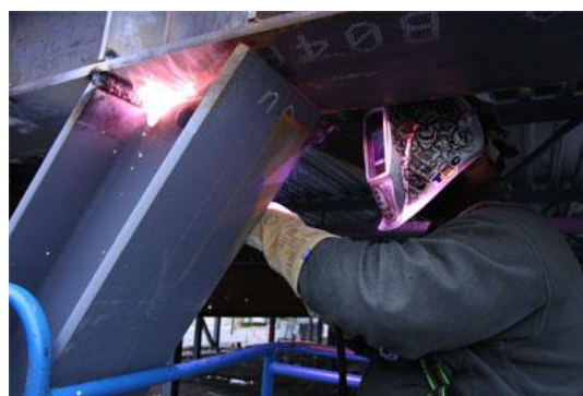
Figura 2. Emprego prático típico do processo de soldagem com Arame Tubular auto protegido para aços estruturais em posições notoriamente não tradicionais. (Fonte: LINCOLN ELECTRIC [11]).
