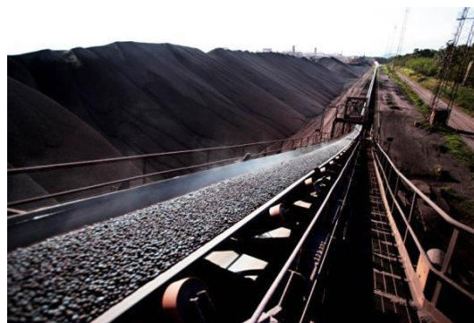
Figura 1. Exemplos de transportadores de correia convencional em operação [6].
