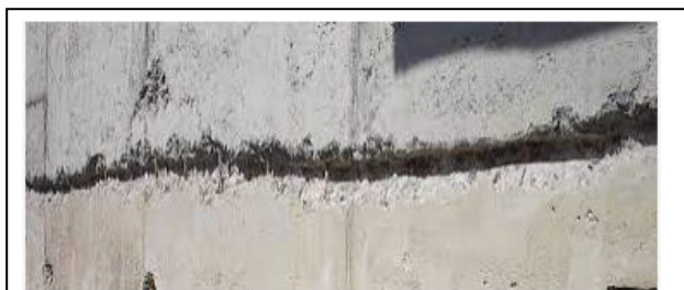
Figura 5. Junta Fria em estrutura de concreto [15].
