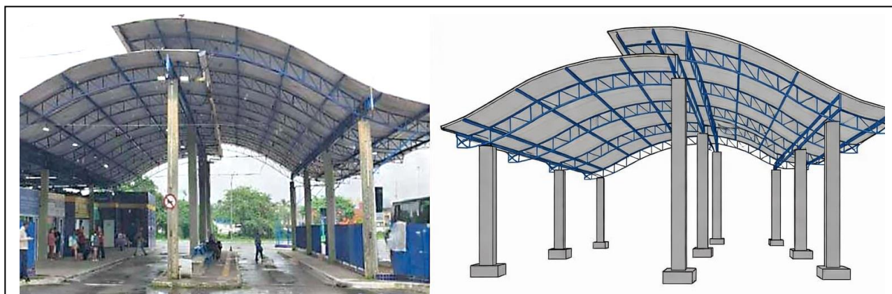
Figura 4. Vista geral da estrutura metálica analisada no estudo de caso, acompanhada de representação esquemática de sua configuração estrutural e sistema de cobertura.
